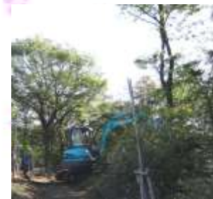
重機による作業
