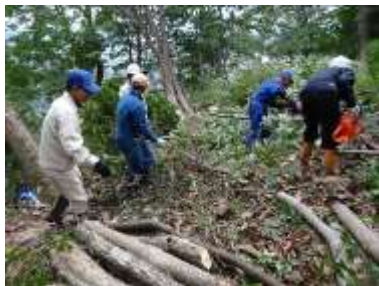
日陰支障樹木伐採の様子
